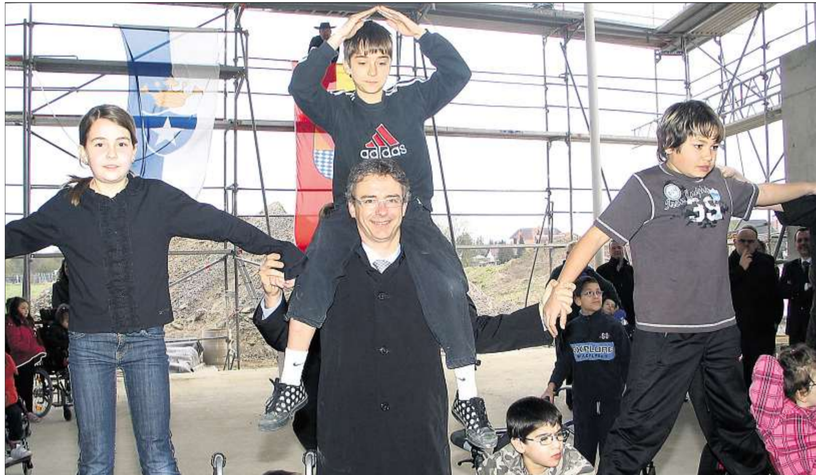
IMMER IN DER BALANCE: Beim Richtfest zum Neubau der Kronauer Außenstelle der Ludwig-Guttman-Schule nimmt Landrat Christoph Schnaudigel während eines Schülerauftritts einen Jungen auf seine Schulter. Das Bauvorhaben kostet rund 3,7 Millionen Euro. Foto: Nees
